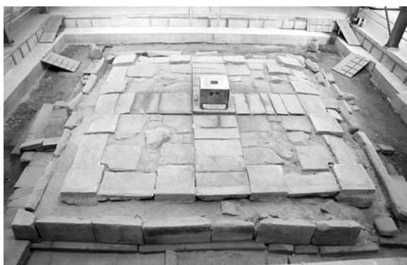
弥勒寺西塔 解体修理状況
